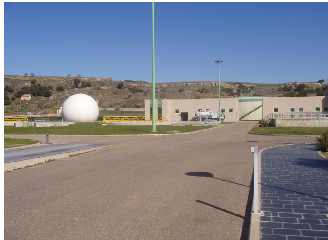
Vista de las Instalaciones de la EDAR de Zamora, de frente se aprecia el Edificio de Servicios.
