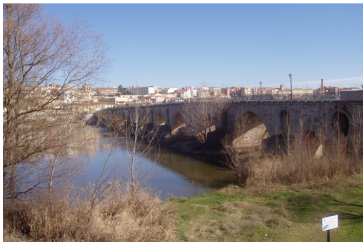
Vista del Puente de Piedra
